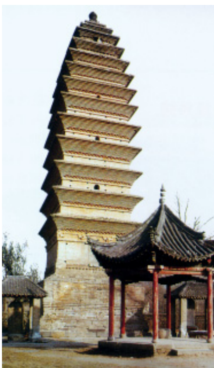
位于白马寺东200米处的齐云塔
