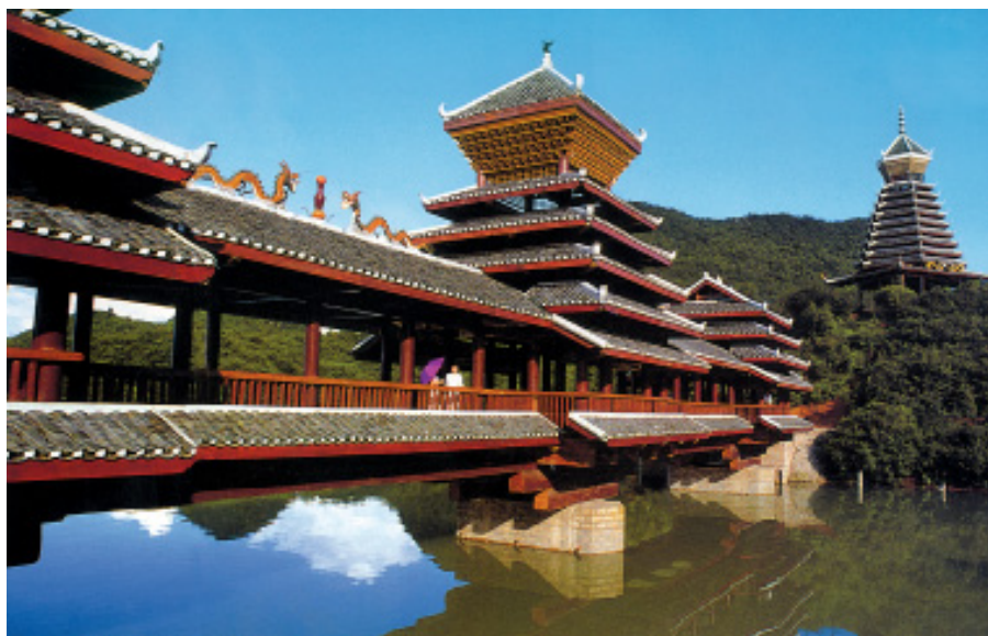
侗寨的标志——风雨桥和鼓楼
