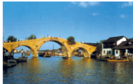
朱家角镇放生桥
